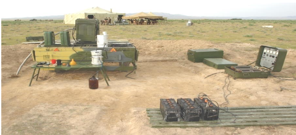
ESB-4VZ-1 zaryadlash va razryadlash agregatining umumiy ko'rinishi
